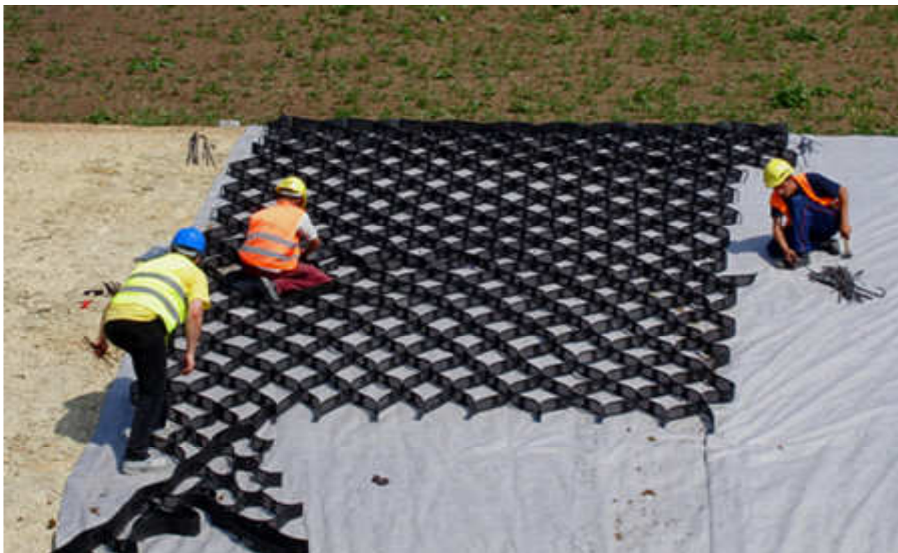
Фото 6. Укладка георешетки на откосе
