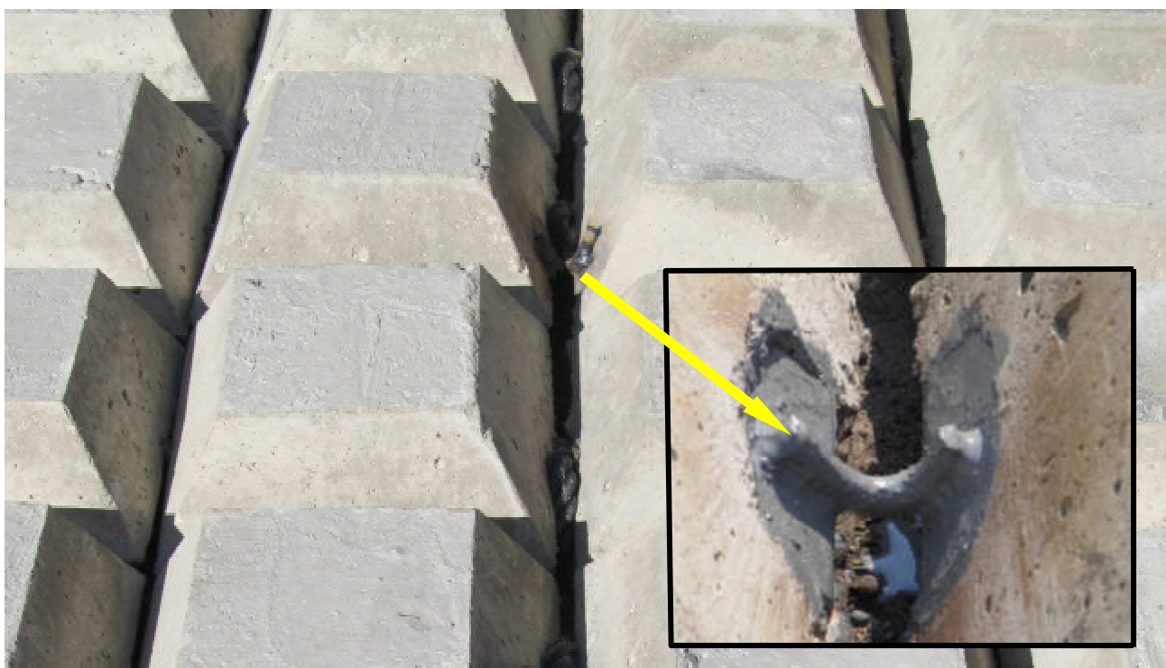
Фото 23. Соединение ГБ-плит между собой методом сварки
