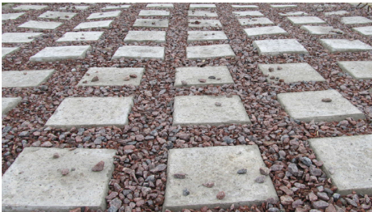
Фото 32. Защита геотекстиля, каната и сварного соединения ГБ-плит
