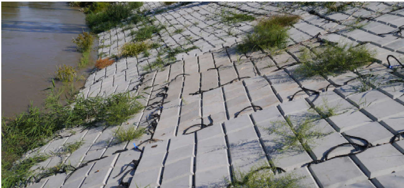
Фото 22. Возвышающиеся над плоскостью ГБ-покрытия такелажные (монтажные, строповочные) петли
