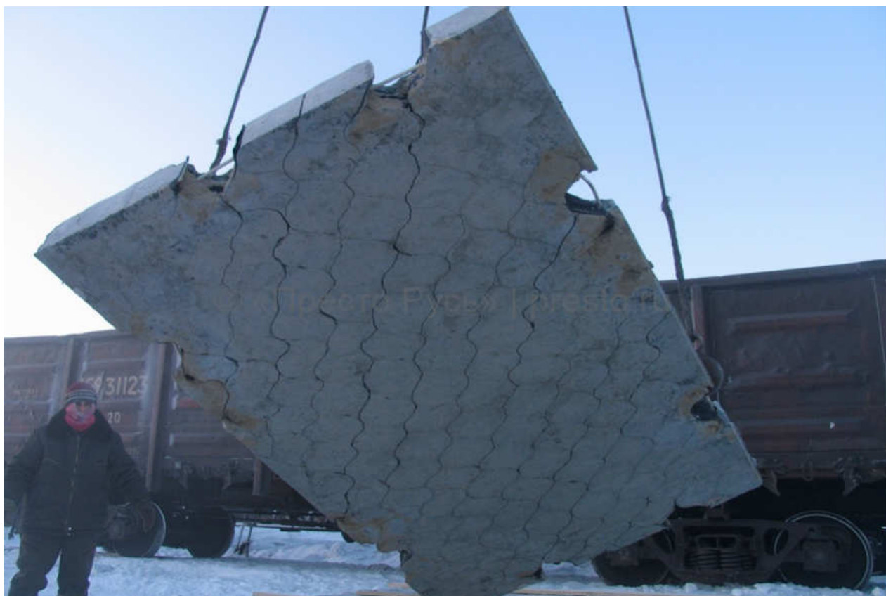
Фото 8. Гибкая бетонная плита ГиБП 2,4.1,5.0,15 Фотография заимствована с сайта ООО "Престорусь"
