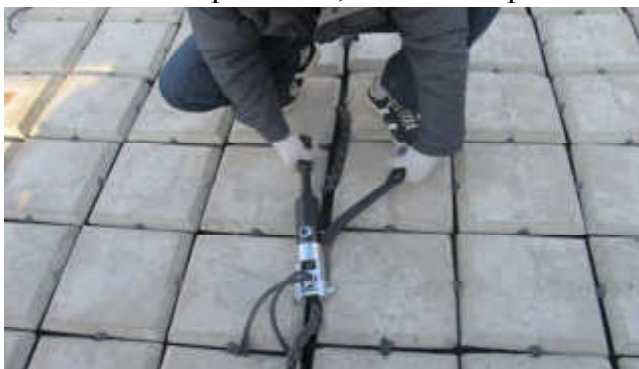
Фото 24. Обжим алюминиевой втулки ручным прессом
