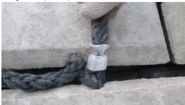
Фото 25. Крепежный узел после завершения обжима втулки
