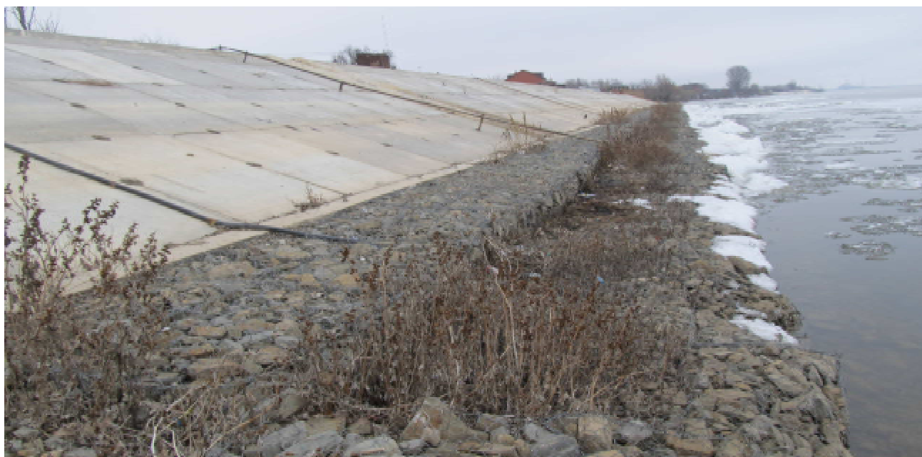
Фото 11. Нижний упор берегоукрепительных сооружений
