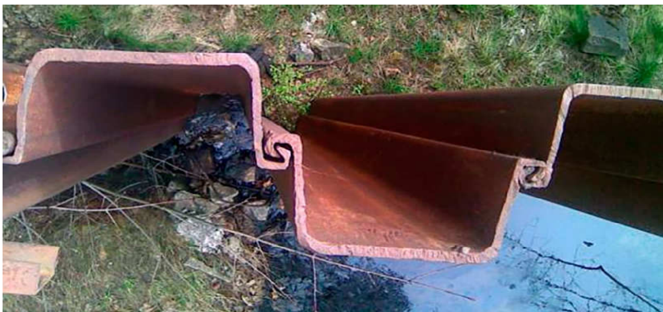
Фото 16. Шпунтовая конструкция (вид сверху)
