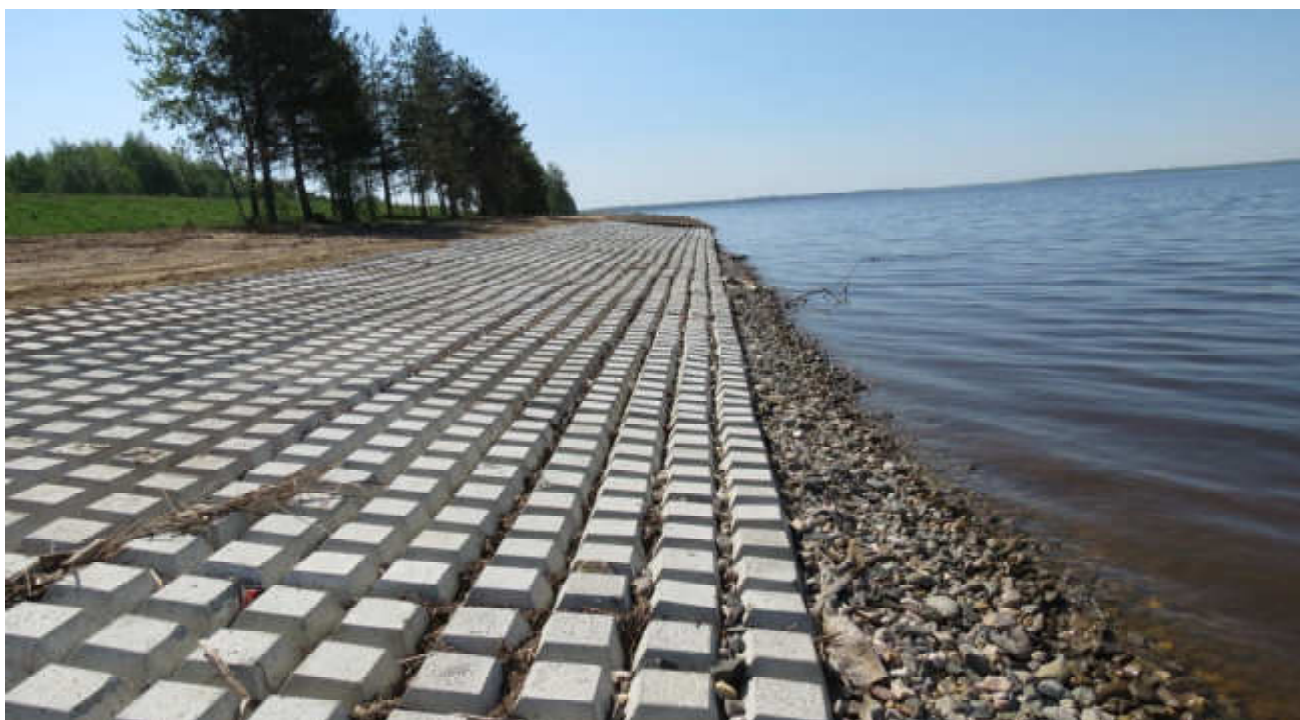
Фото 34. Использование в качестве противосуффозионного элемента гальки, щебня или камня
