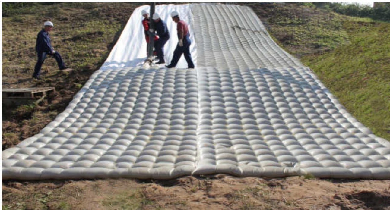
Фото 10. Геотекстильная оболочка БетоБОКС в процессе наполнения бетонной смесью
