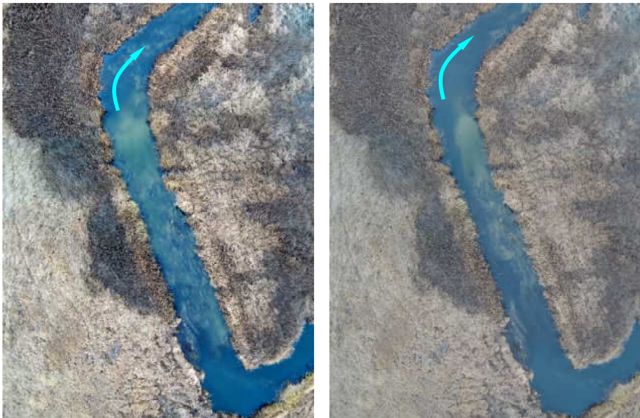
Фото 43 и 44. Исходная и разрушенная переливная грунтовая плотина
