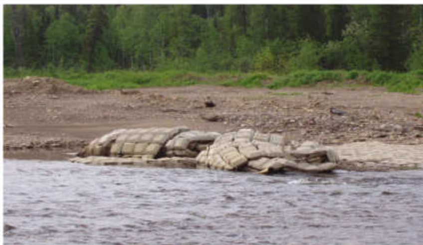
Рисунок 21 – Не скрепленные между собой ПБЗГУ
