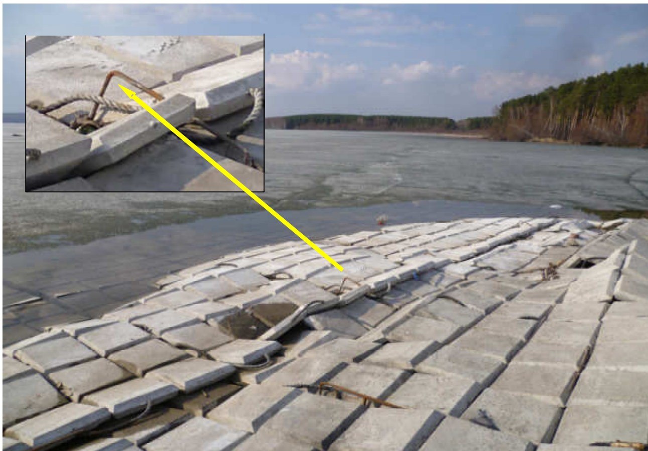
Фото 27. Результат скрепления ГБ-плит П-образными скобами, не имеющими якорных зацепов, и без приваривания к закладным деталям
