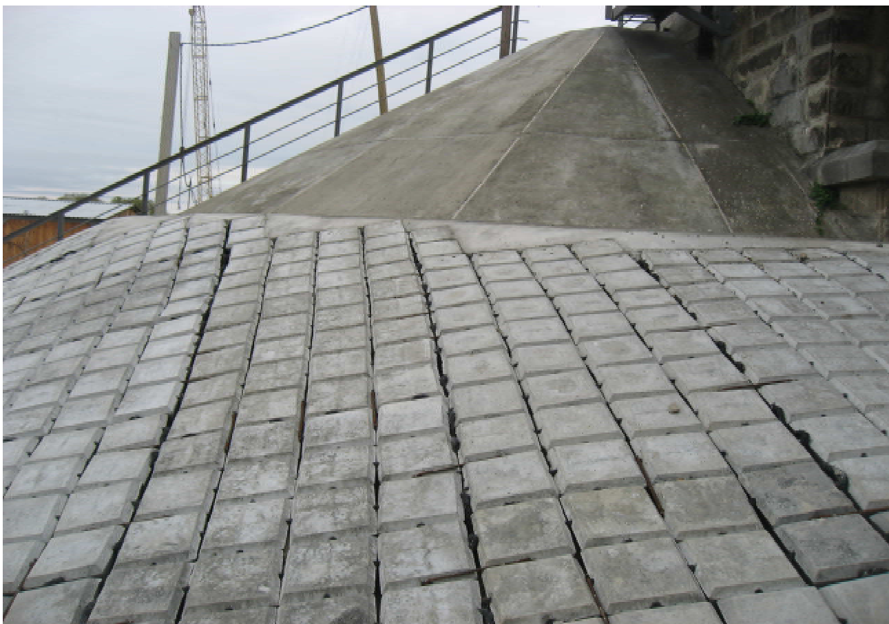
Фото 58. Защита устоя моста ГБ-плитами
