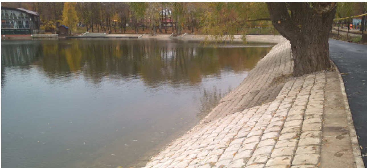
Фото 39. Декоративная отделка водоема с использованием ГБ-плит
