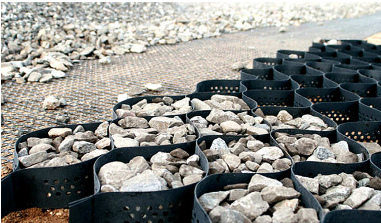
Фото 7. Заполнение георешетки щебнем
