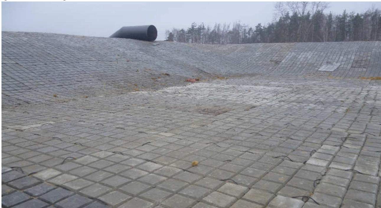
Фото 46. Пруд-накопитель, построенный с использованием ГБ-плит
