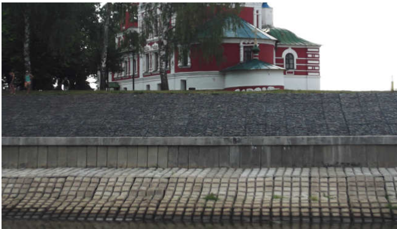
Фото 35. Комбинированные берегоукрепительные сооружения с использованием ГБ-плит, железобетонных и габионных конструкций
