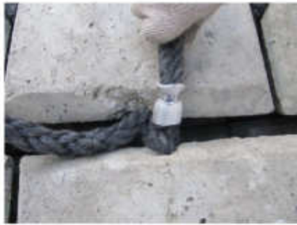
Рисунок 2 – Скрепление ПБЗГУ за ДМК обжимной втулкой
