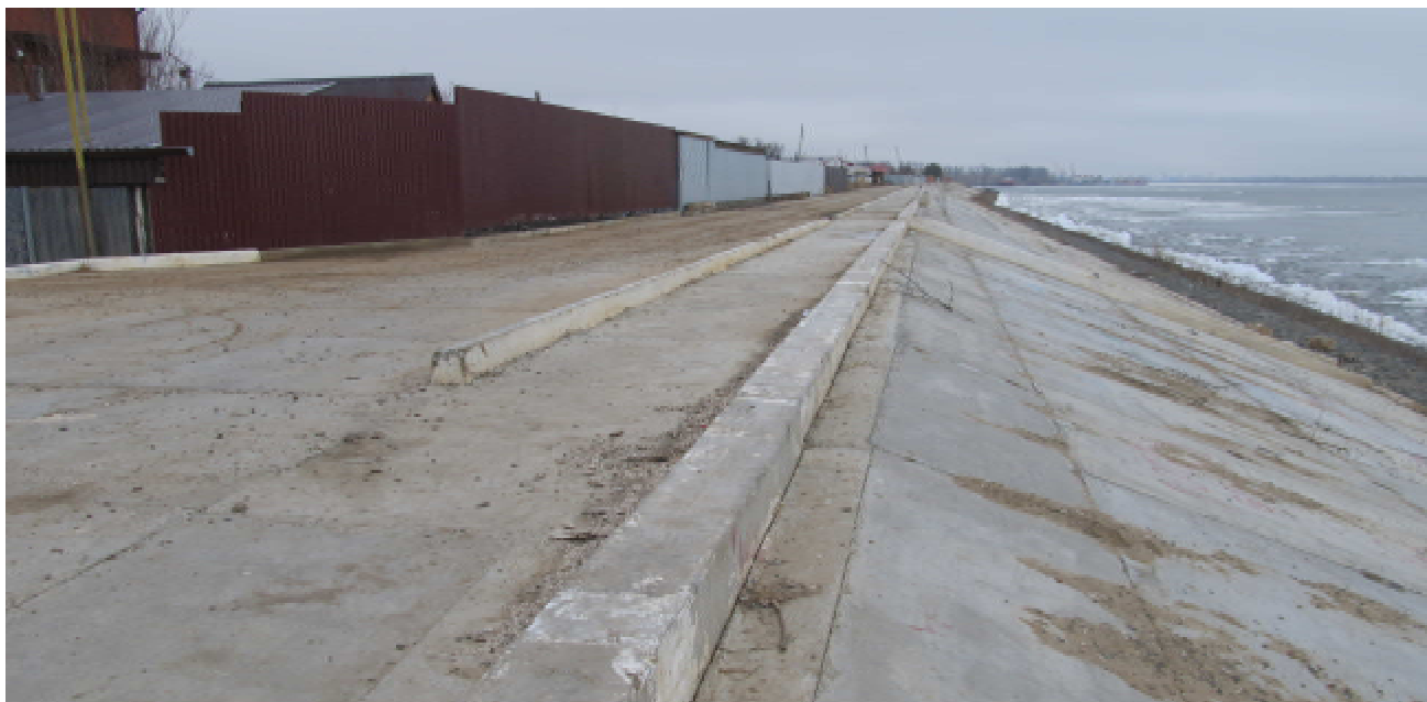
Фото 12. Верхний упор берегоукрепительных сооружений
