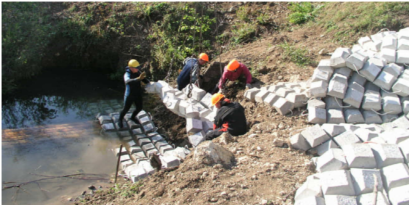
Фото 38. Использование ГБ-плит при защите трубопроводов подводных переходов
