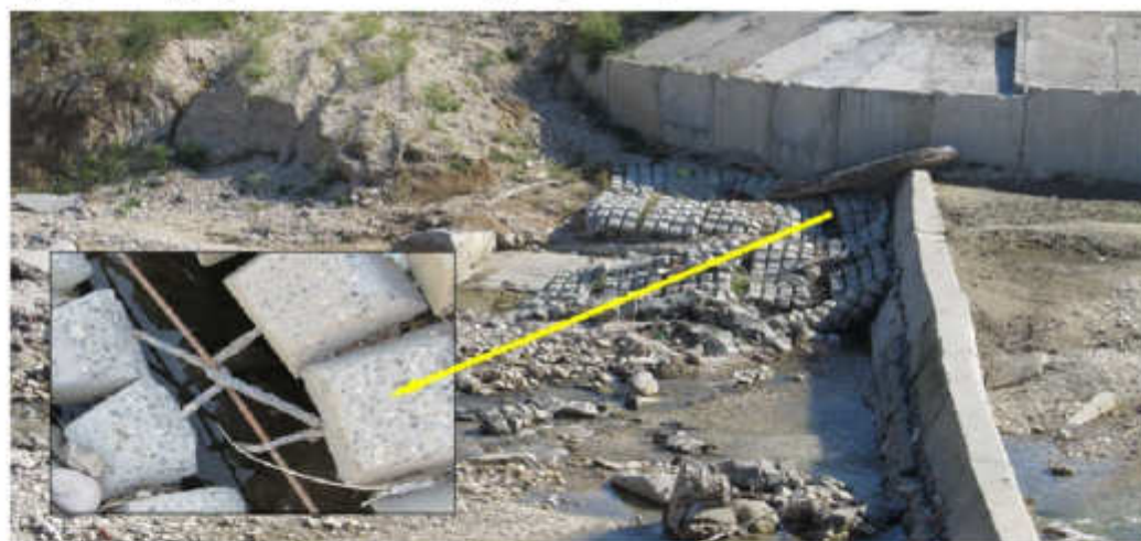
Рисунок 25 – Скрепление ПБЗГУ между собой за строповочные (такелажные, монтажные) петли
