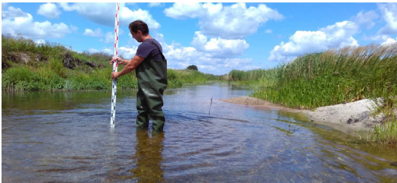
Фото 45. Обмеление реки Усмань в результате разрушения грунтовой переливной плотины
