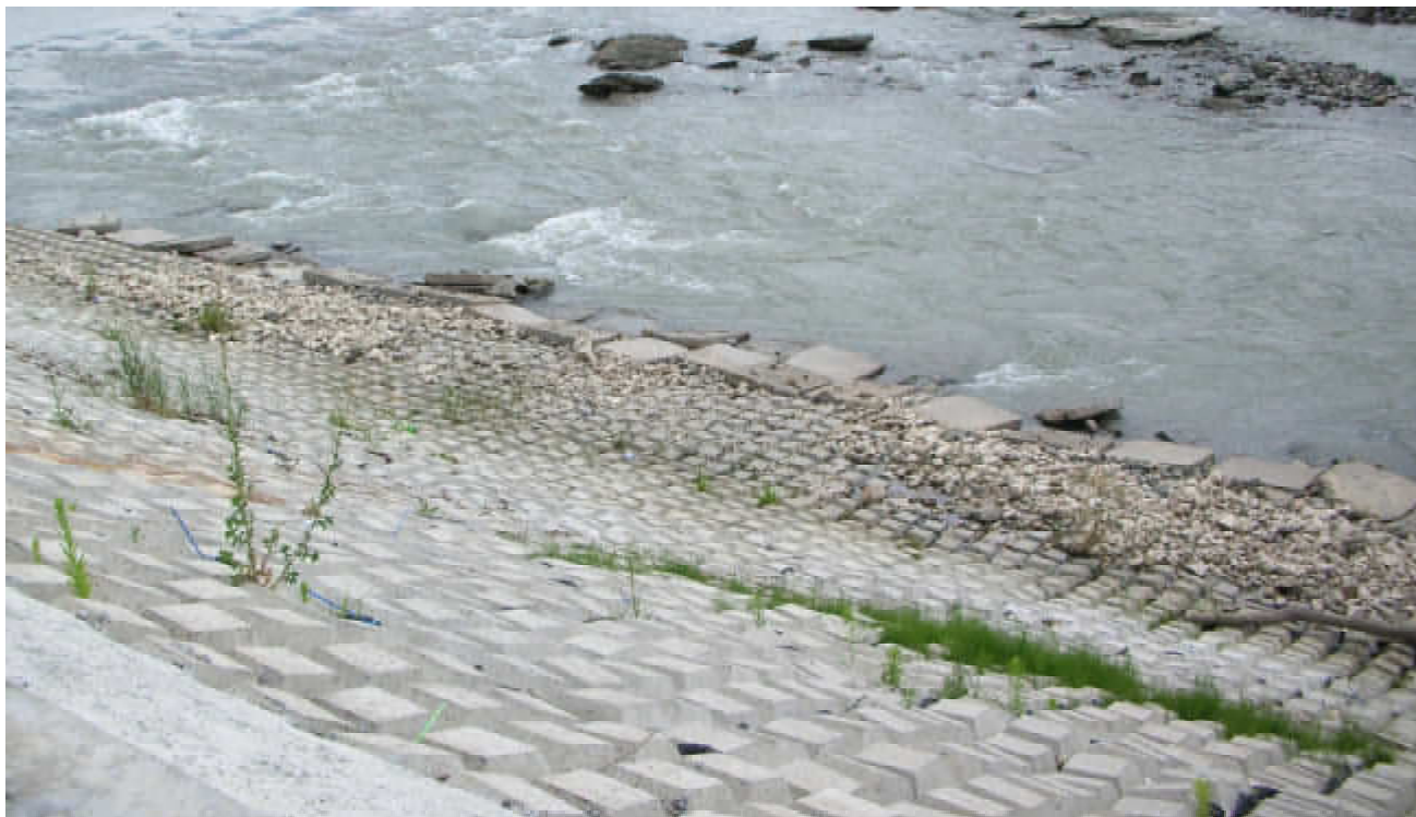
Фото 28. Устойчивость ГБ-покрытия, закрепленного на береговом откосе "методом подвешивания", при разрушении нижних упоров
