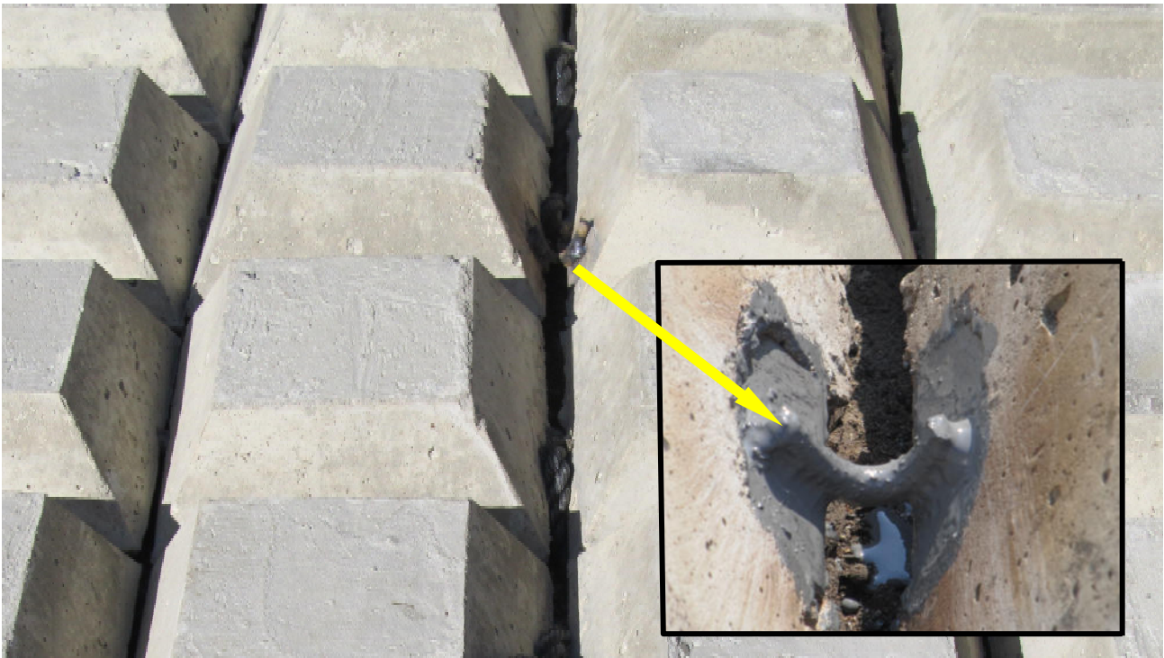
Фото 1. Соединение ГБ-плит между собой методом сварки
