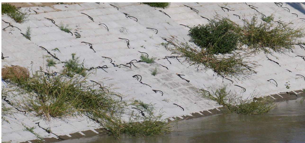
Фото 4. ГБ-маты с возвышающимся над поверхностью ГБ-покрытия такелажными (монтажными, строповочными) петлями
