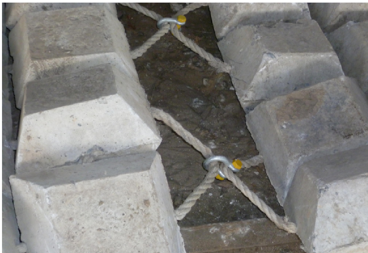
Фото 3. Зазор между ГБ-матами при их скреплении за такелажные (монтажные, строповочные) петли
