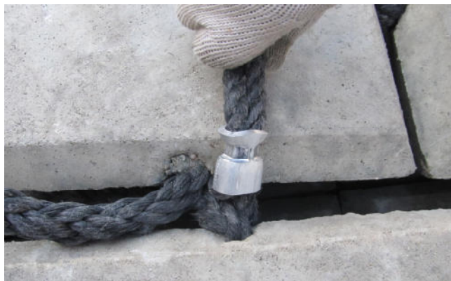
Фото 2 Б. Крепежный узел после завершения обжима втулки
