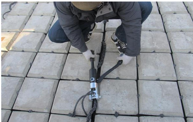
Фото 2 А. Обжим алюминиевой втулки ручным прессом
